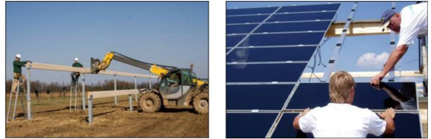
Illustration 25 : Montage des structures porteuses et des modules
